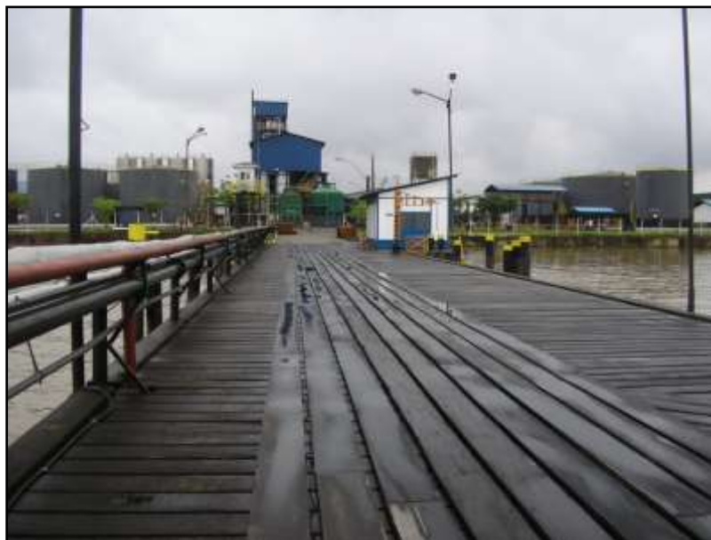
Figura 12 – Complexo Industrial da CRA localizado no bairro do Tapanã/Belém.
