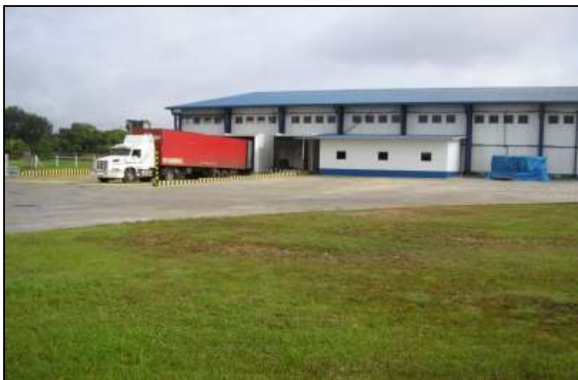
Figura 13 – Unidade Geral Acondicionamento – UAG.
